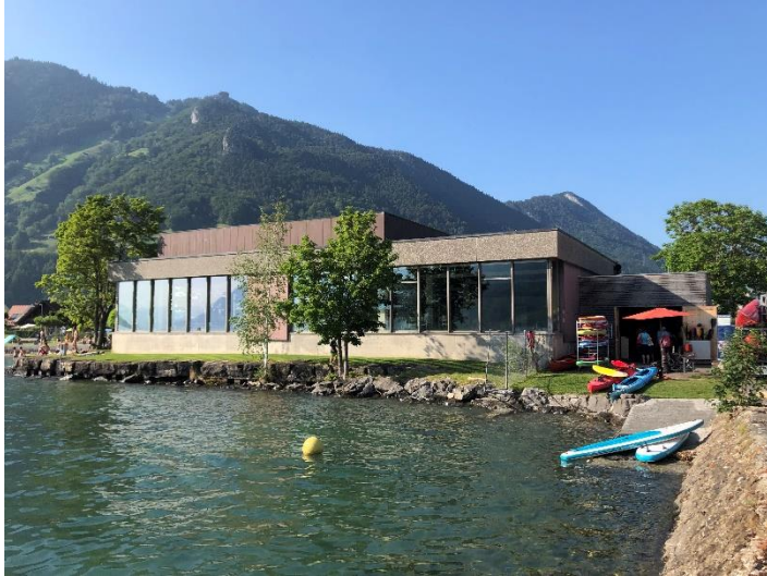
Hallenbad Brunnen © Gemeinde Ingenbohl, Fotografin Irène May
